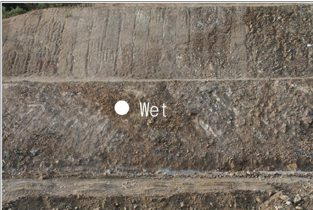
【그림 17】 A 영역 상세사진 (지하수 유출)
