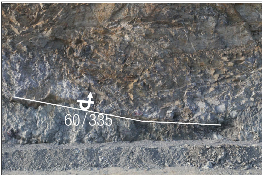
【그림 26】 C 영역에 발달한 불연속면
