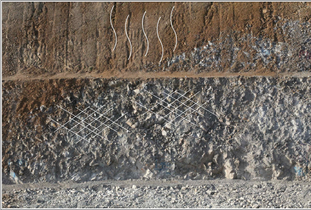
【그림 16】 A 영역 상세사진 (세편화된 암석)
