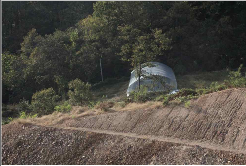
【그림 5】 상부 구조물-비닐하우스(STA.4+660~670 부근)
