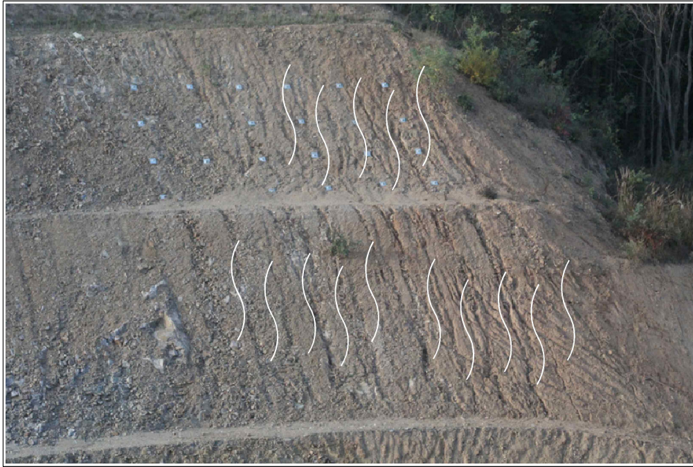
【그림 34】 D 영역 상세사진 (토사유실 및 우류침식)
