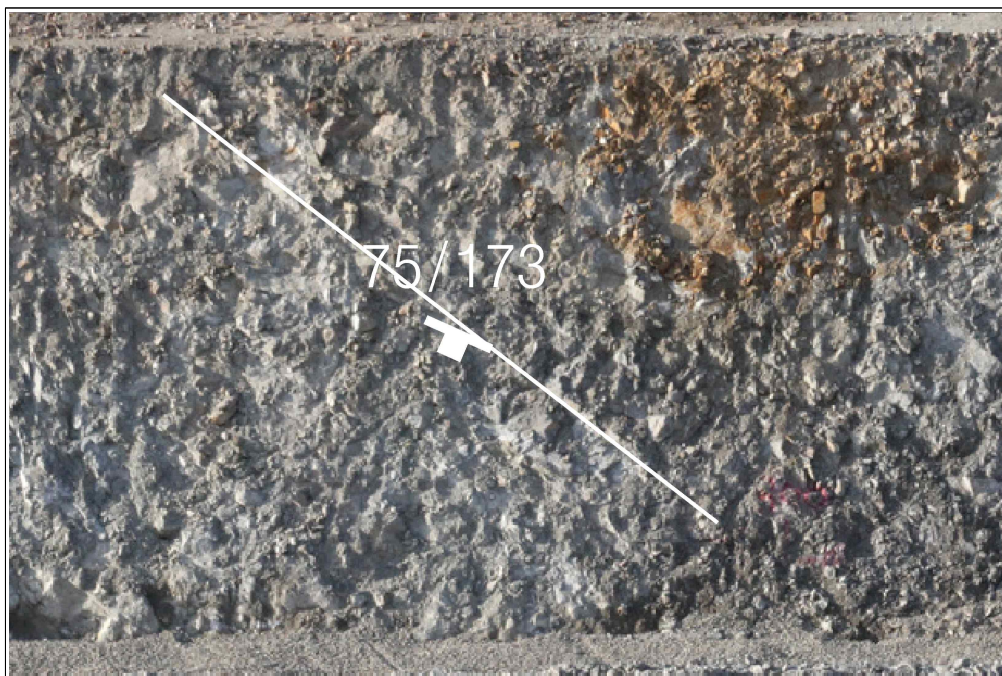
【그림 18】 B 영역에 발달한 불연속면
