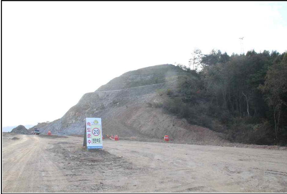
【그림 3】 깎기비탈면 시점부 측면 사진
