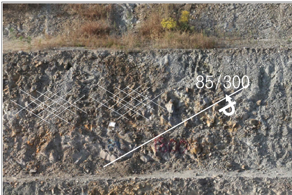
【그림 20】 B 영역에 발달한 불연속면
