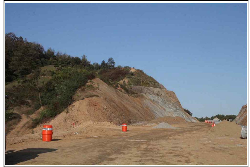
【그림 4】 깎기비탈면 종점부 측면 사진
