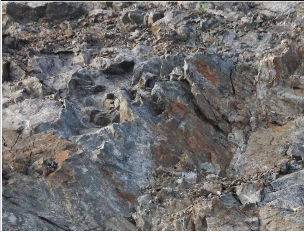
【그림 31】 C 영역 상세사진 (이완된 암편)
